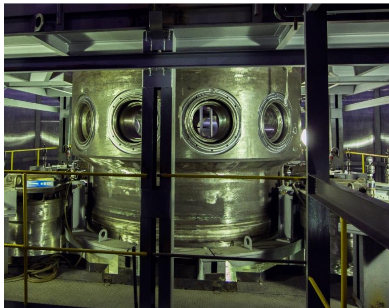
Рисунок 3. Стапель сборочный (авторская разработка) для выполнения на одном рабочем месте нескольких уникальных технологических переделов: «управляемая» сварка гидрокамер, сборка внутрикорпусных устройств и фланцевых разъёмов, рентгенконтроль и гидроиспытания
